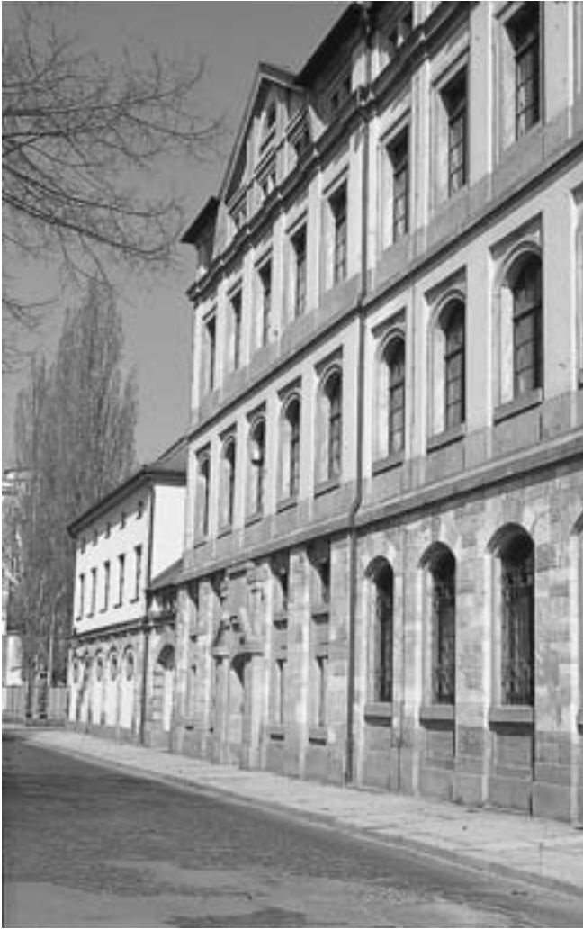
Stadtarchiv Chemnitz, Außenansicht
