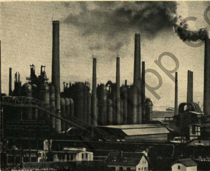
▲ Die Völklinger Hütte, bekannt als Röhrlingsche Eisen- und Stahlwerke GmbH., verfügt über eine fünf Batterien zählende Kokerei, sechs Hochöfen, vier SM-Öfen von je 60 t und fünf Thomaskonverter, ein Elektro-Stahlwerk mit vier Lichtbogenöfen und einen Mittelfrequenzofen, sowie entsprechende Walzenstraßen.
