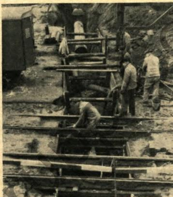
Die Osterfelder Straße kurz vor dem Zementwerk mußte gesperrt werden. Das war notwendig, da die neue 700er-Rohrleitung beim Verlegen vom Emscherwasserwerk zum Stahl- und Walzwerk unter einen Straßenkanal durchgeführt werden mußte. Die neue Leitung dient mit zur Wasserversorgung der Stahl- und Walzwerke Neu-Oberhausen.
