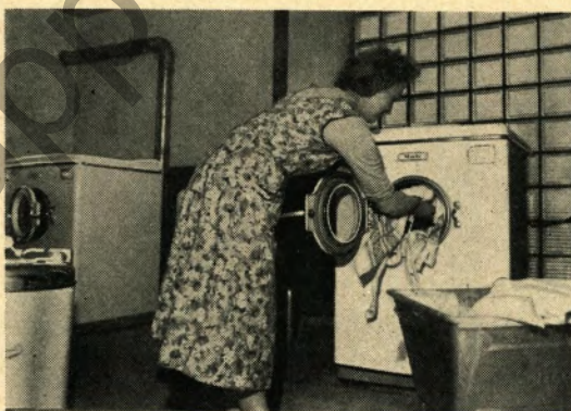
Auf dem Dach über dem Treppenhaus befindet sich die Waschküche mit modernen Wasch- und Trockenmaschinen. Großen Waschtag hat Frau Anneliese Brünken aus dem vierten Stock.
