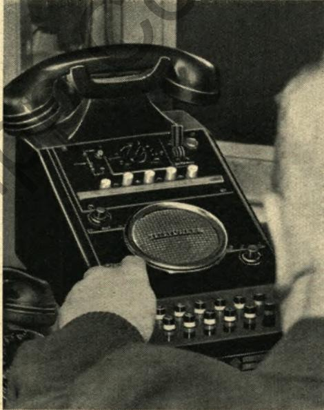
Vorn die Selektivruf-Anlage, mit der jede Lok einzeln angerufen werden kann. Der Lautsprecher der gewünschten Lok öffnet sich dabei automatisch.
