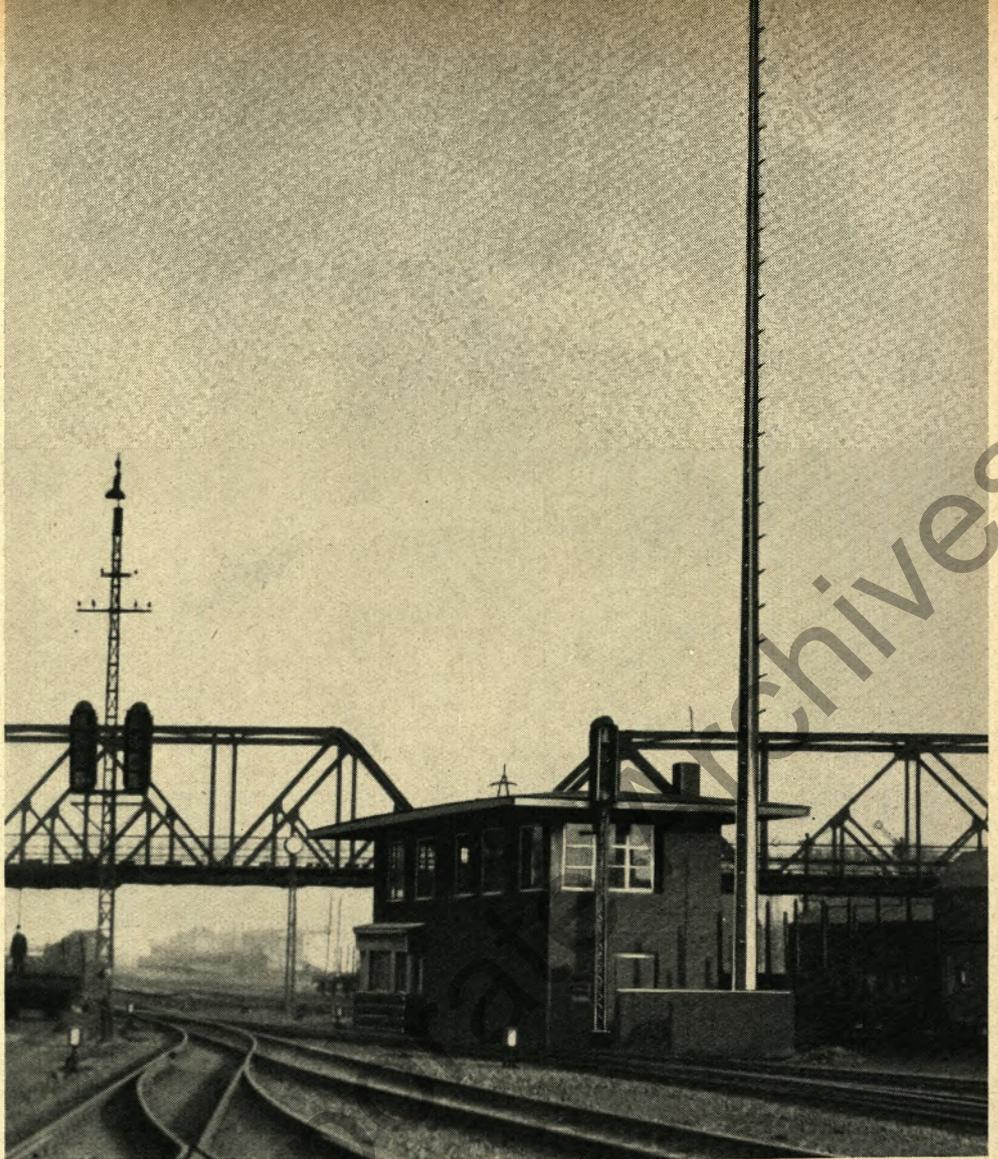
Der Betrieb im Stahl- und Walzwerk „hängt“ am Stellwerk Frintrop. Hier gehen die Anrufe aus dem Betrieb ein: eine Lok wird angefordert. Über UKW wird sie von hier aus schnell angerufen und an ihren Bestimmungsort gewiesen. Rechts neben dem Stellwerk der hohe Sendemast der Ultrakurzwellen-Funkanlage.
