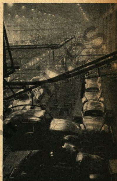
Rohmontageband. Kettenförderer bringen die Einzelteile (Türen, Kotflügel usw.), wo sie zur Rohkarosserie zusammengesetzt werden.
