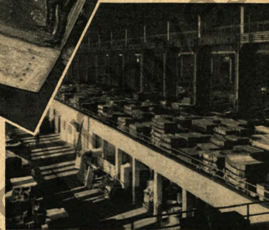
Frisch aus dem Hüttenwerk eingetroffene Feinblechstapel, ihre Verarbeitung warten. Große Mengen an Stahlblechen täglich benötigt, aus denen die Ganzstahlkarosserien gefertigt werden.
