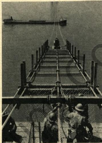
Für die Monteure, die zwischen den Pylonen die Seile spannen und später an Kabelschellen die Hängeseile befestigen, wurde von Pfeilern zu Pfeilern ein engmaschiges Drahtnetz gespannt.
