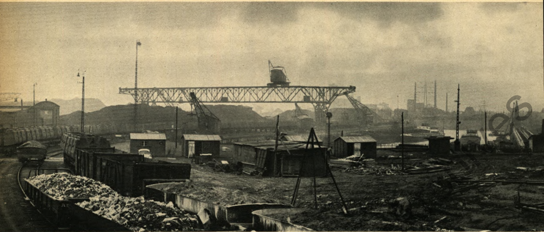
Im Hafen Walsum sind die Arbeiten für die Erzaufbereitungsanlage zügig vorangeschritten. Unsere Panorama-Aufnahme der Großbaustelle am Lehmberg gibt ein gutes Bild von den
