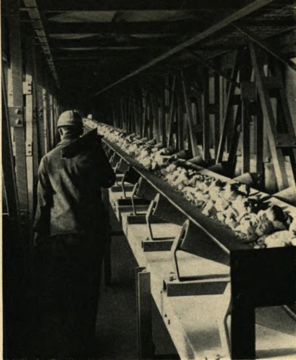
Unsere beiden Bilder oben links und oben rechts zeigen Teile der neuen Kalkbeschickungsanlage auf Neu-Oberhausen. Über Förderbänder (Bild links) gelangt der Kalk aus den Bunkern der Dolomithalle in einen Sammelbunker im Thomasstahlwerk. Von hier aus kann der Kalk nach Bedarf in Kübelwagen abgefüllt werden. Der Bau der Kalkbeschickungsanlage erfolgte im Zusammenhang mit dem Neubau der Dolomithalle, über die wir später einmal auf der Schnappschußseite berichten werden.
