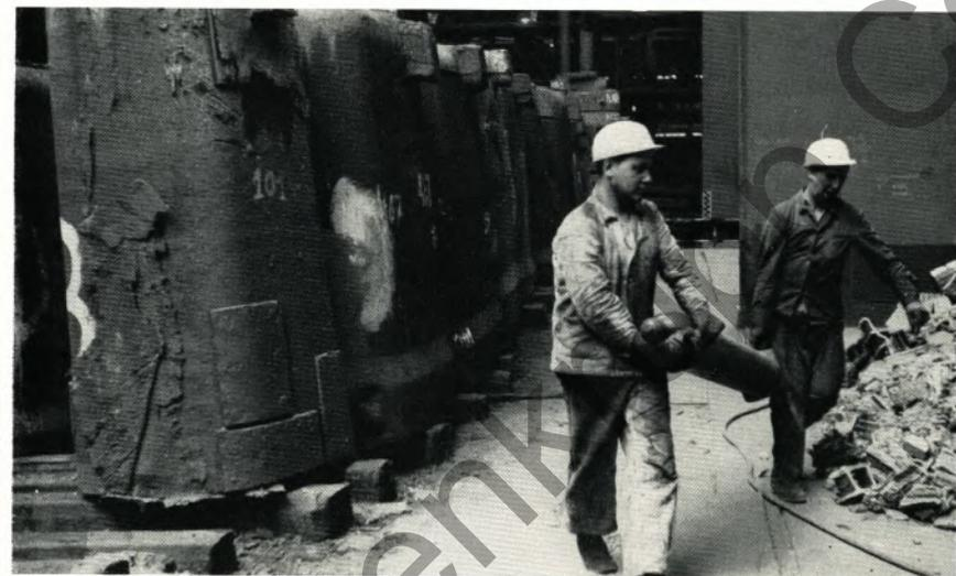
Gasflaschen dürfen weder in der Nähe von Wärmequellen aufgestellt noch dort vorübergehend gelagert werden. Hier wird eine Gasflasche, die auf einem Schutthaufen herausgeborener heißer Ofensteine (ca. 150° C) lag, auf Anweisung des Sicherheitsingenieurs forttransportiert.
