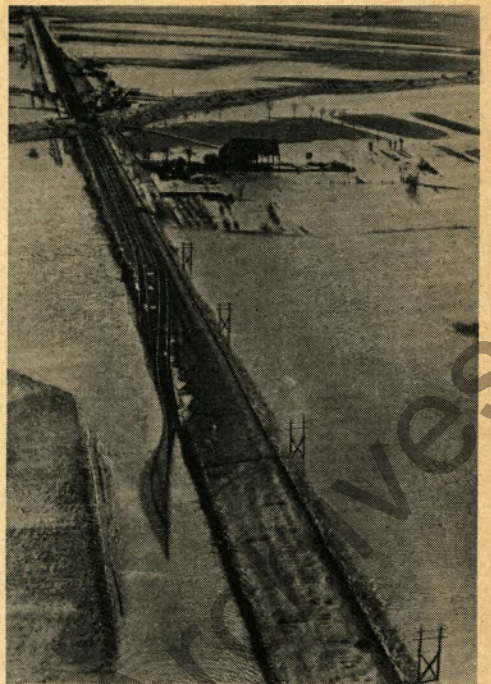
▲ Selbst Eisenbahnschienen wurden hinweggefegt, so enorm war die Kraft der gegen die Dämme antobenden Wassermassen. Das Meerwasser verwandelte fruchtbares Land in eine salzige Wüste. Selbst heute sind die Spuren noch nicht restlos beseitigt.
