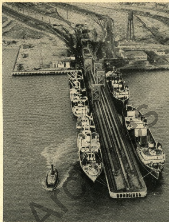
Der Kohleexport, insbesondere in die Montanunionsländer, hat in den letzten Jahren eine immer größere Bedeutung für den amerikanischen Bergbau erlangt. Moderne Verladeeinrichtungen wie hier in Newport News (Virginia) an der Atlantikküste ermöglichen eine schnelle Beladung von gleichzeitig vier Kohlefrachtern.
