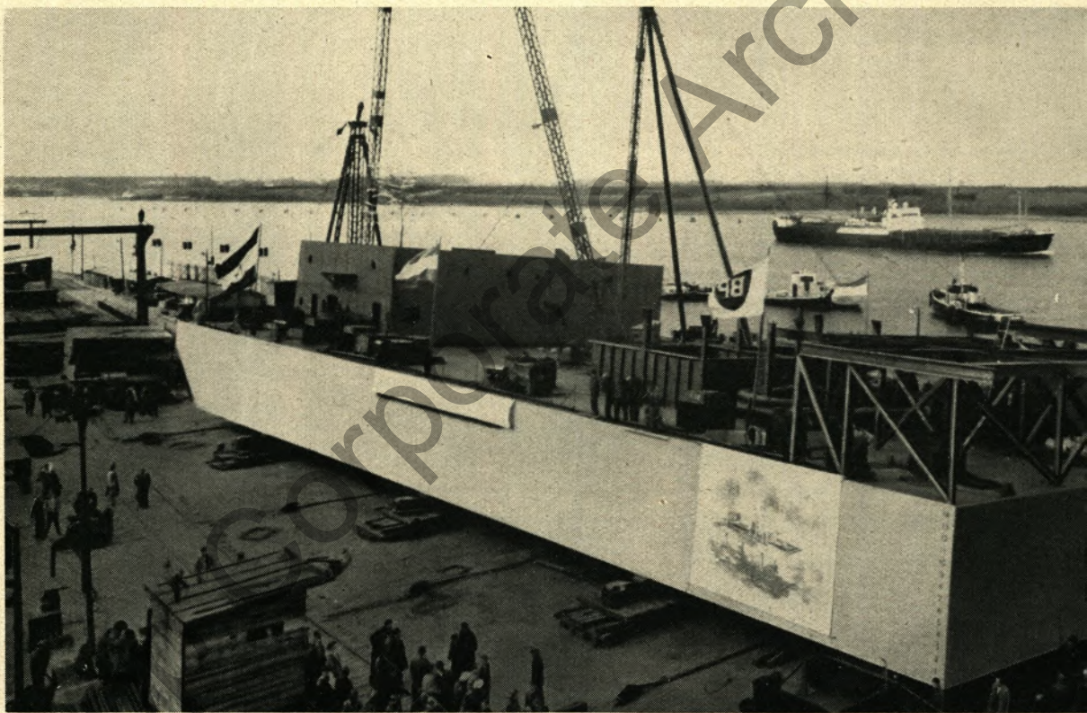
Dieses Foto hat den Moment vor dem eigentlichen Stapellauf festgehalten. Noch halten Trossen und Bremsklötze den Koloß in seiner Lage, um wenige Minuten später den Weg ins nasse Element freizugeben. Deutlich erkennt man die Aufbauten des Deckshauses, in dem Wohn-, Schlaf- und Aufenthaltsräume für etwa 50 Personen eingerichtet werden, dazu Büro- und Sanitätsräume. Im August wird die Stahlinsel, die auf ausfahrbaren Stützen im Wasser stehen wird, zum Persischen Golf geschleppt werden. Ihre Maße: 68 x 32,5 x 4,6. Die Bohrinsel soll helfen, Erdöl unter dem Meere zu finden. Der 48 Meter hohe Bohrturm, der noch montiert werden muß, ermöglicht Bohrtiefen bis zu 7000 Meter. Auftraggeber ist die BP Benzin- und Petroleumgesellschaft.
