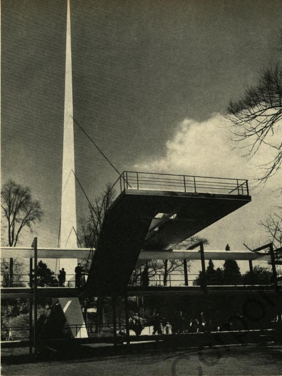
▲ Die Wirtschaftsvereinigung Eisen- und Stahlindustrie stiftete diese 60 Meter lange Stahlhängebrücke für Fußgänger, die über eine landschaftliche Unebenheit zum deutschen Pavillon führt. Die asymmetrische Brücke mit dem 50 Meter hoch ragenden Pylon ist eines der interessantesten Bauwerke der Weltausstellung.
