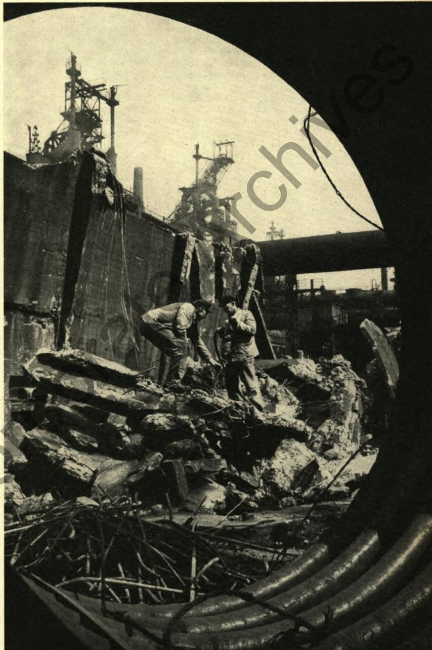
▲ Die bizarren Trümmer des im Kriege zerstörten Kühlturmes müssen jetzt dem neuen Hochofen weichen, der an dieser Stelle errichtet werden soll. Ein Blick durch ein Gichtgasrohr.
