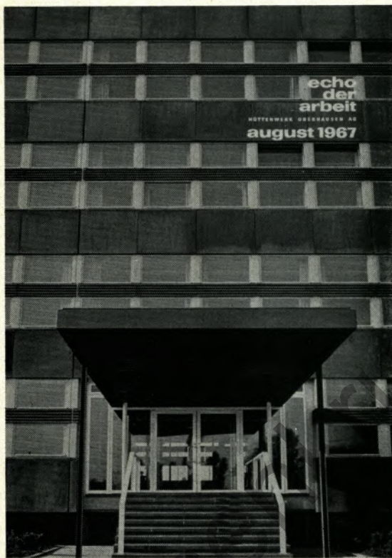
COR-TEN-Stahl bestimmt das äußere Bild des Stranski-Instituts für Metallurgie der Hüttenwerk Oberhausen AG, das am 14. Juli 1967 seiner Bestimmung übergeben wurde. Dieser von unserem Unternehmen hergestellte witterungsbeständige Stahl erfordert für den Gebrauch im Freien keinerlei Rostschutz-Maßnahmen
