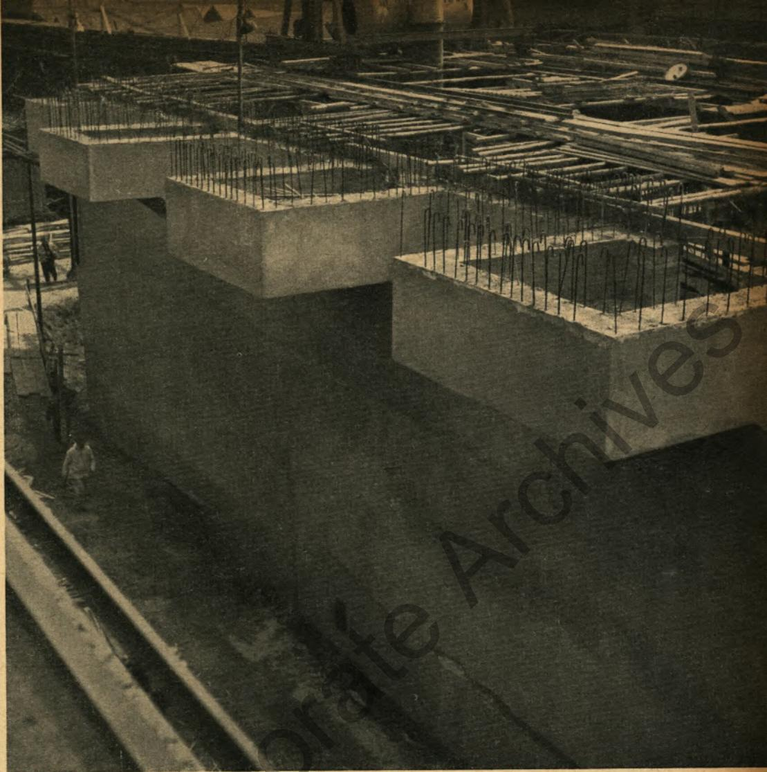
So sieht der zwölf Meter hohe Betonklotz, der Meter um Meter in die Erde abgesenkt wird, von oben aus.
