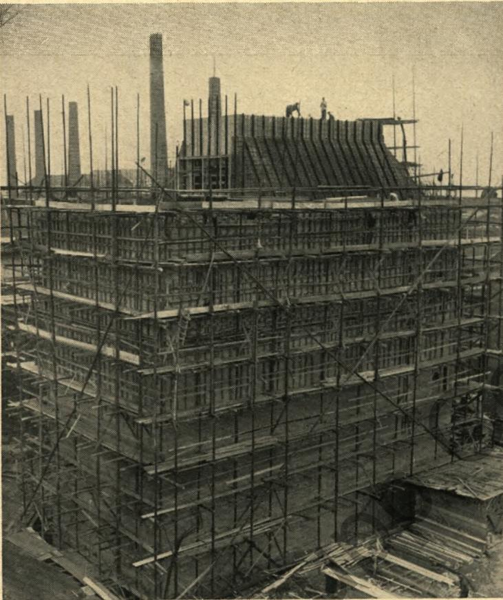
▲ Für die Blockstraßen 1 und 2 sowie für die Fertigstraßen wird ein Sinterbecken von fast 26 Meter Höhe bei 23 Meter Länge und 12 Meter Breite und einer Höchstleistung von 3200 cbm Wasser pro Stunde gebaut. Nach Fertigstellung der Klotz aus Eisenbeton im Caissonverfahren in die Erde abgesenkt.
