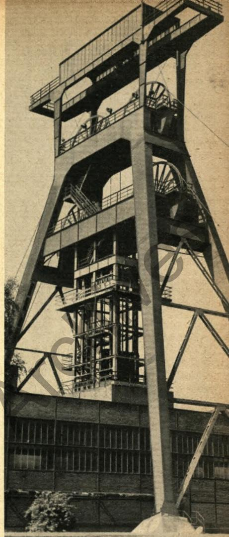
Stahlbau gab dem Revier das Gesicht. Hier das Fördergerüst der Zeche Auguste-Viktoria, Marl-Hüls. Das Gerüst baute die GHH Sterkrade, die Seile lieferte unser Werk Gelsenkirchen. Aber auch unter Tage findet der Werkstoff Stahl beim Gruben- und Streckenausbau weitgehend Verwendung. Stählerne Rippenkörbe und Stempel sind der beste und sicherste Schutz des Kumpels gegen den ungeheuren Bergedruck.
