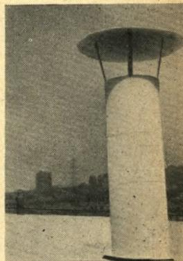
Diese Bilder zeigen die Kamine der Elektrofilter der Kohlenmahlanlage (links) und der Mahltrocknungsanlage. Der Reinigungsgrad der Abgase, die hier austreten, beträgt 99 Prozent.
