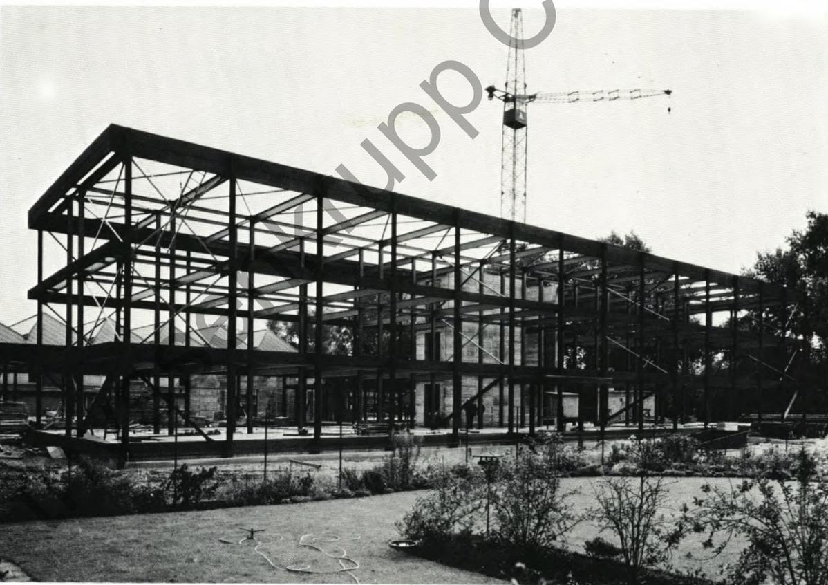
*Das Stahlskelett des BFI-Rohbaues, das zum Teil aus dem wetterfesten Stahl COR-TEN besteht. Die Vorteile des Stützenkühlsystems sind vielfältig. Architekten haben jetzt die Möglichkeit, wetterfesten Stahl unverkleidet als Konstruktionselement in die Verkleidung mit einzubeziehen, ohne das damit der Brandschutz beeinträchtigt wäre.*
