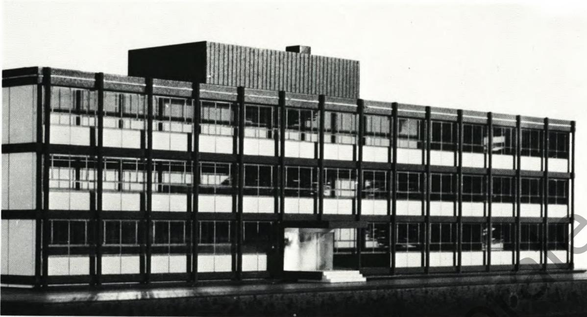
*Modell des neuen Betriebsforschungsinstituts in Düsseldorf. Dieses Institut wird als dreigeschossiges Gebäude mit einer Laborhalle an der Sohnstraße in Düsseldorf errichtet. Das Kühlsystem, das in zwei voneinander getrennte Zonen unterteilt ist, besteht aus den 30 Außenstützen, die mit etwa 10000 Liter Kühlflüssigkeit gefüllt sind. Im Keller und auf dem Dach sind Verbindungsrohre installiert, die beiden Hochbehälter sind im Dachaufbau untergebracht.*
