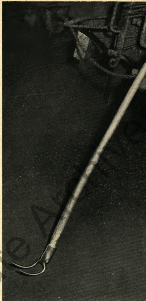
► In der Nagelputzkammer im Werk Gelsenkirchen ist es nun einmal ziemlich dunkel. Ob da dieser Kratzer, mit dem die Nägel aus den Trommeln geholt werden, sehr vorteilhaft hingestellt ist? Wenn der Stiel mit Wucht gegen den Kopf saust, nachdem er unbedacht auf die Hakenzähne trat, wird das bestimmt nicht behaupten. Die eingeschlagene Stirn könnte vermieden werden — allerdings: eine halbe Sekunde Überlegen beim Wegstellen des Kratzers ist schon nötig.
