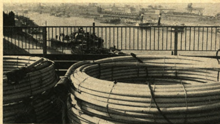
Insgesamt mußten 76 solcher Seilrollen von Gelsenkirchen nach Ruhrort geschafft werden. Dabei konnten nur immer zwei dieser schweren Brocken auf jeweils einen Lastwagen mit Anhänger verladen werden. Mehr ließ die polizeiliche Vorschrift nicht zu.
