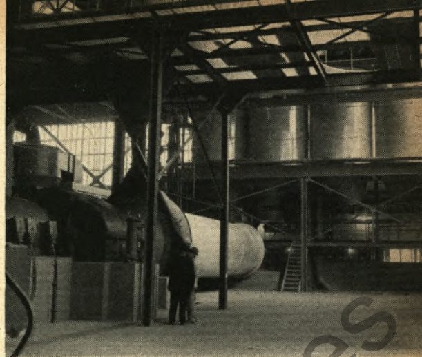
360 bis 400 Sack Hüttenzement erzeugt die neue Dreikammermühle stündlich. Sie wurde bereits Anfang Juni in Betrieb genommen und dient genau wie der neue Ofen der Modernisierung des Betriebes.
