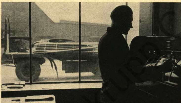
Bevor der Transport das Werk verläßt, geht's auf die Waage. Die Seile werden nochmals gewogen. Das ist Erfordernis eines ordentlichen Geschäftsablaufs. Annähernd acht Tonnen wiegt so ein Kabel, wie wir es auf der Ladefläche des Anhängers liegen sehen.
