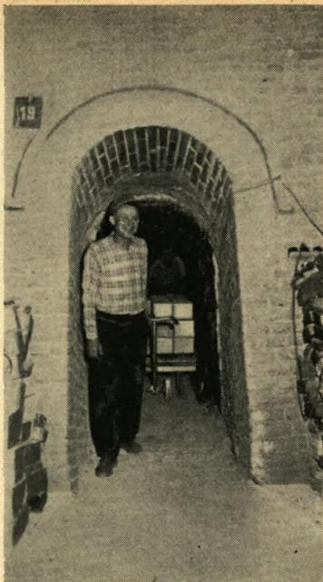
Das Bild zeigt den Zugang zu einer der vielen Kammern des kreisförmig angelegten Ringofens, in dem der Ton gebrannt wird.
