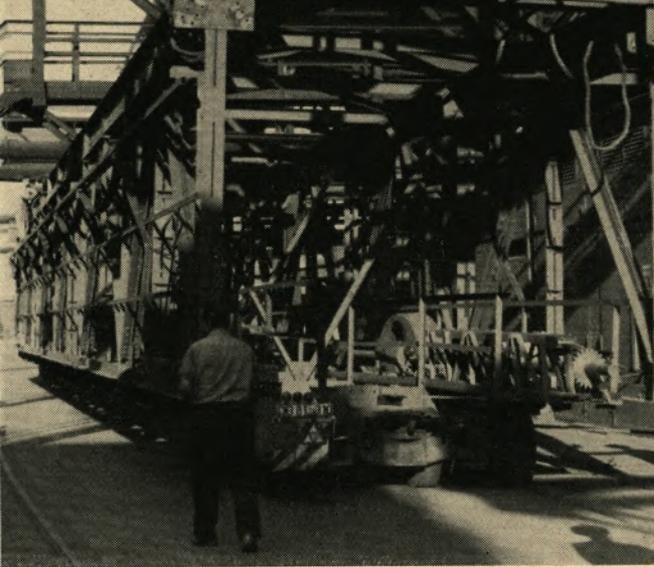
▲ Große Schwierigkeiten verursachte der Transport einer 35 Tonnen schweren und 36 Meter langen Kranbrücke vom alten Winkeleisenplatz zum neuen Trägerplatz. Die Konstruktion wurde nicht auseinandergenommen, sondern auf einen Straßenroller der Bundesbahn geladen. Bei der Fahrt durch den Betrieb gab es jedoch viele Transportprobleme zu lösen.
