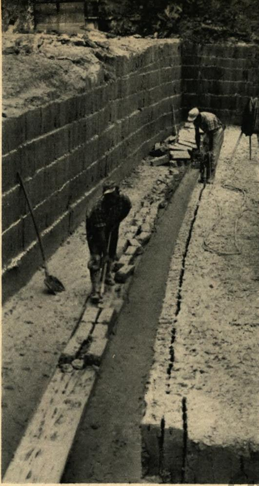
Die Tonschollen werden über eine Blechrutsche, die mit Wasser glattgehalten wird, in Loren geschoben. Unser Bild zeigt deutlich den Hergang des Tonstechens.
