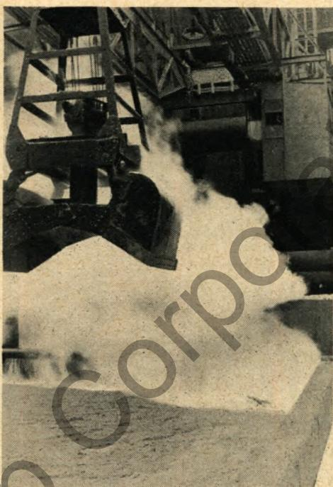
Mit diesem Zwischalengreifer (Greiffähigkeit 1,6 cbm) der Eisenhütte wird Sand aus der Schlackekörnungsanlage auf Talbotwagen verladen.
