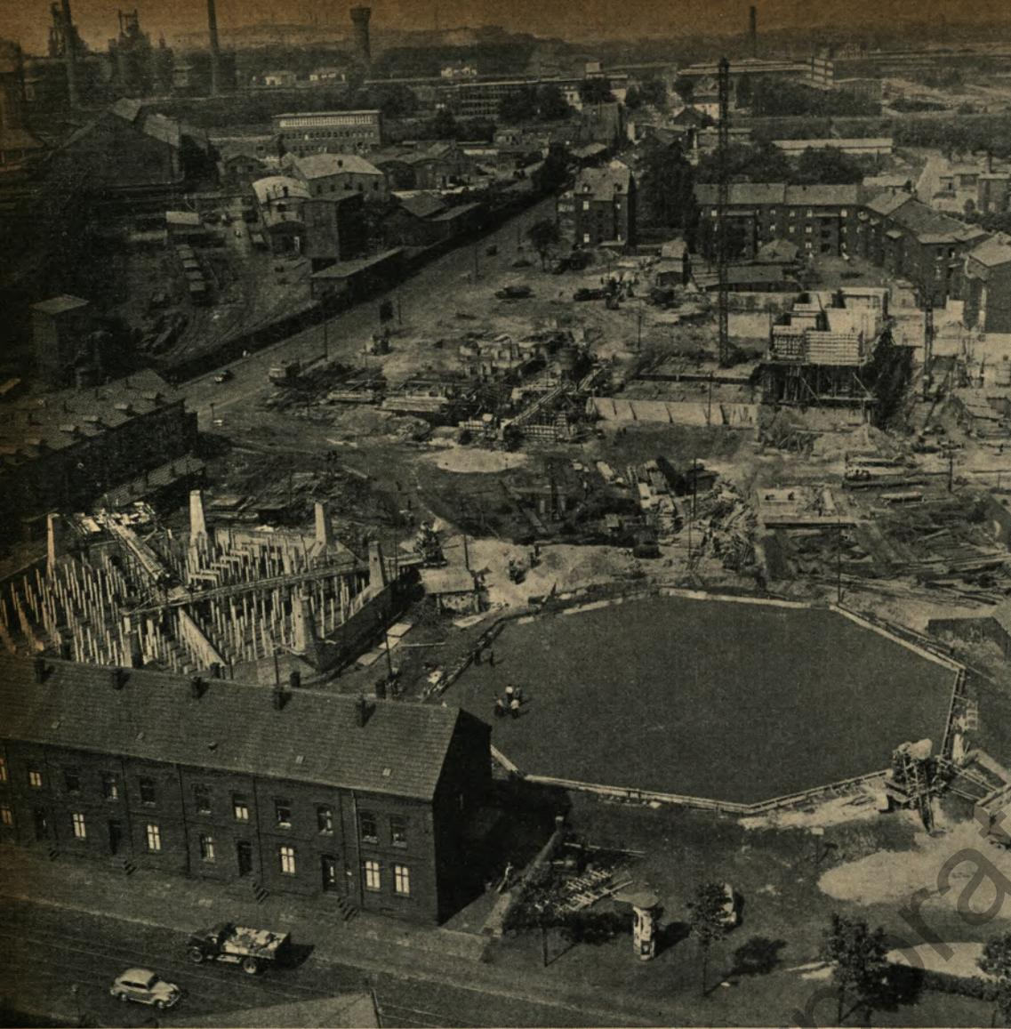
Ein Blick aus luftiger Höhe auf die Baustelle zwischen Hultschiner-, Osterfelder- und Essener Straße. Im Vordergrund zwei Kühlturm-Fundamente, dahinter wird das Maschinenhaus erstellt. Rechts der Montagemast für die Kessel und die Schalung für die Kohlenhochbunker.
