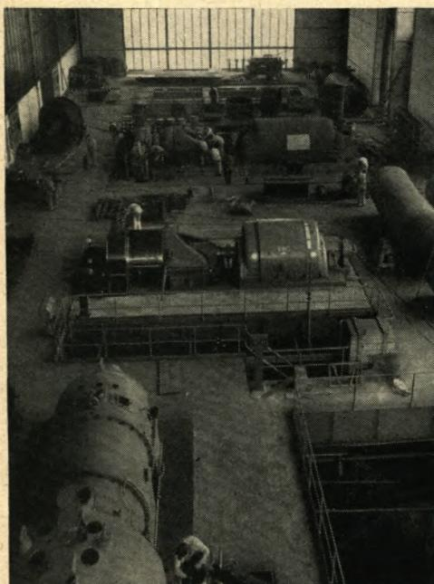
Blick in die Maschinenhalle. Vorn ein Vorschalt-, dahinter der Nachschalt-Turbosatz und das Hochofengebläse I.
