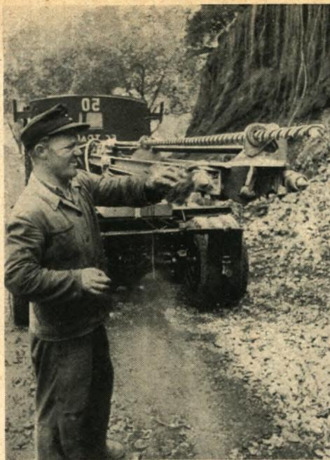
Mit Hilfe modernster Bohrergeräte werden Sprenglöcher bis tief in das Innere des Schlackenberges hinein gebohrt.
