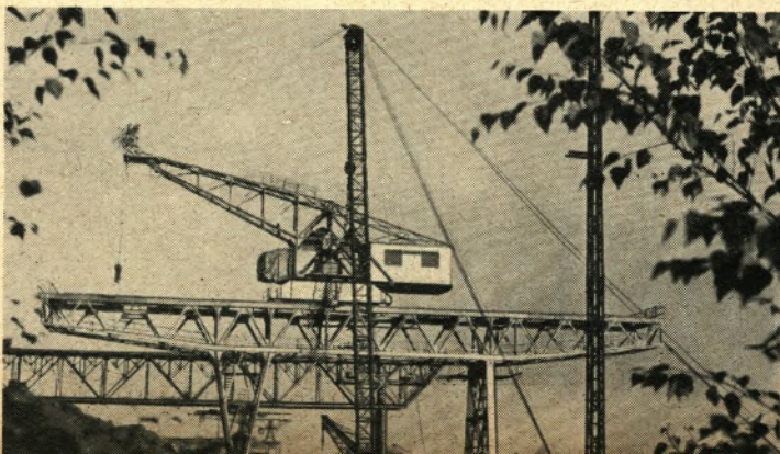
Nun konnte auch der zweite der beiden neuen Portalkräne des Erzlagerplatzes im Südhafen Walsum fertiggestellt werden. Über den Bau berichteten wir laufend in den letzten Ausgaben. Die Erzverladung wird durch die neuen Kräne wesentlich beschleunigt, da sie eine Reichweite von je dreizehn Metern haben.
