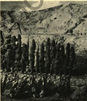
▲ Reihensprengung im Abbaurevier von Malmberget. Wie eine Reihe von Pappeln steigen die Rauchsäulen von der Terrassenkante auf. Mehrere tausend Tonnen angefallenen Erzes liegen danach bereit und warten auf Verladung.
