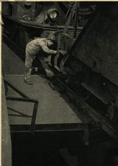
▲ Auf der Hochbahn über den Erztaschen der Eisenhütte II bestand vor allem für Rangierer die Gefahr, acht Meter tief hinabzustürzen. Erich Pilarczik sah das; auf seine Anregung wurde hier eine Plattform angebracht. In Verbindung mit einem Geländewagen wurde so die Unfallgefahr weitgehend vermindert.
