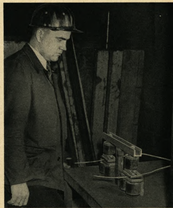
▲ Beim Umbau der Walzen an der 550er- und 450er-Strandwalze mußte der zum Befestigen der Kupplungen benötigte, an den Enden glühende Eisendraht quer durch die Halle zu den Walzgerüsten geworfen werden. Theo Mathuis schlug vor, für die Erwärmung der Drahtenden neben den Walzgerüsten einen Glühtransformator aufzustellen. Die Arbeit ist nun einfacher und gefahrlos.
