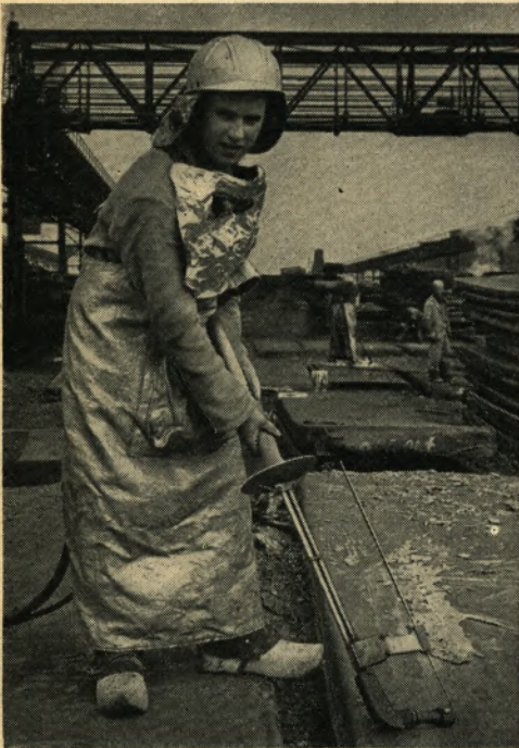
▲ Helmut Schulz vom Blockplatz hat bereits zweimal Verbesserungsvorschläge eingereicht. Beide wurden angenommen. Schulz entwickelte einen einfachen Holzgriff, mit dem der Brei-flämmer leichter gehandhabt werden kann. Außerdem verbesserte er den Sitz der beim Flämmen benutzten Schutzbrille.
