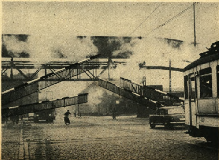
▲ Fußgänger und Autofahrer haben es inzwischen mit Erleichterung festgestellt: Die Schranken auf der Essener Straße an Tor 8 öffnen sich schneller. Wenn die Knöpfe am Bedienungs Brett gedrückt waren, dauerte es bisher sechs bis sieben Sekunden, bis die Schrankenbäume sich hoben. Durch den Antriebsumbau der Schrankenanlage in diesen Tagen entsteht jetzt praktisch kein Verzug mehr.
