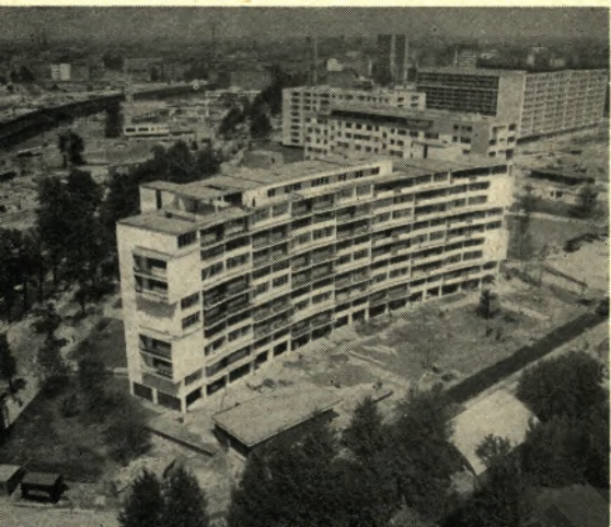
▲ Die einzigartige internationale Ausstellung, die den Wiederaufbau eines ganzen durch Kriegseinwirkungen zerstörten Stadtteils zeigte, schloß in diesen Wochen ihre Pforten. Das Herz der dreimonatigen „Interbau“ waren die neuen Wohnhäuser, Bürogebäude, Kirchen und Schulen, die im Hansaviertel nahe der Ostberliner Grenze wie Pilze aus dem Boden schossen. Unser Bild zeigt einen Blick auf das Gebiet, auf dem namhafte Architekten ihre Pläne verwirklichten.
