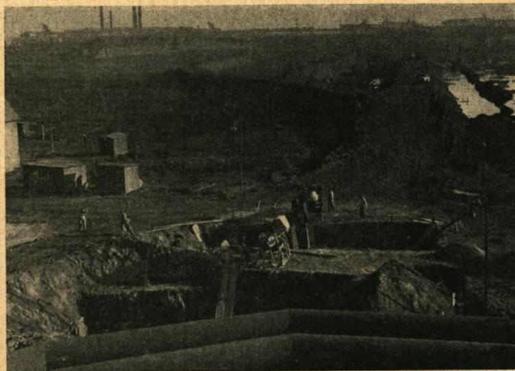
Zwischen dem Zementwerk und der Fahrradhalle gegenüber dem Tor 10 sind zur Zeit Erdarbeiten in vollem Gange. Hier soll einmal die neue Feineisenstraße gebaut werden. Die gesamte Halle wird etwa 3,70 Meter über dem jetzigen Gelände liegen. Im übrigen werden die Fundamente für die projektierte Straße praktisch auf dem Erdboden errichtet, um später seitlich mit Erde ausgefüllt zu werden. Auf diese Art und Weise wird der Höhenunterschied gut ausgeglichen. —
