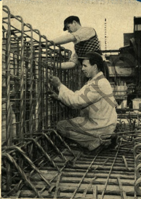
Dieses dichte Torstahlgewebe dient zur Bewehrung von tragenden Mauern des gegenwärtig im Bau befindlichen Warmbetts der 750er Straße.
