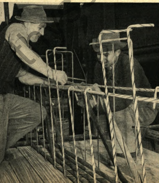
Die Verwendungsmöglichkeiten von Torstahl im Betonbau sind sehr umfassend. Auf diesem Bild entsteht die Torstahl-Bewehrung eines Deckenträgers für eine höhere Belastung.
