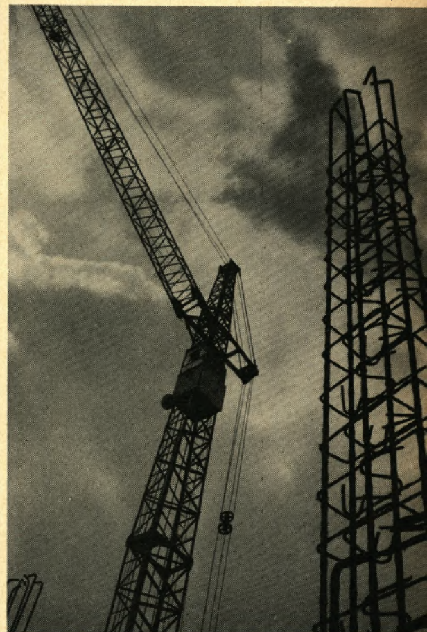
Dieses dichte Torstahlgewebe dient zur Bewehrung von tragenden Mauern des gegenwärtig im Bau befindlichen Warmbetts der 750er Straße.
