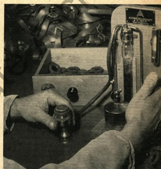
▲ Die Masken werden ständig überprüft. Eine beschädigte Maske ist völlig nutzlos. Auf unserem Bild werden die Ausatemventile an einem besonders hierfür konstruierten Apparat auf ihre Dichtigkeit überprüft. Es geht darum, unsere Lungen gesund zu halten.
