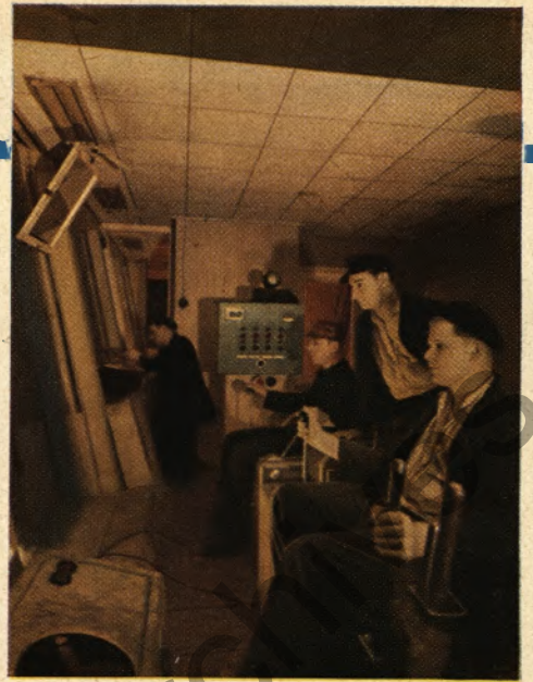
Blick in das „Hirn“ des Blockwalzwerks, wie man vielfach die Steuerbühne bezeichnet. Von hier aus wird die Arbeit der Blockstraße durch Betätigung von Schalthebeln und -knöpfen wie von Geisterhand dirigiert. Die Anlage ist auf den modernsten Stand der Technik gebracht; wo früher die Walzmannschaften schwerste körperliche Arbeiten leisten mußten, genügt heute der Druck auf einen Knopf.
