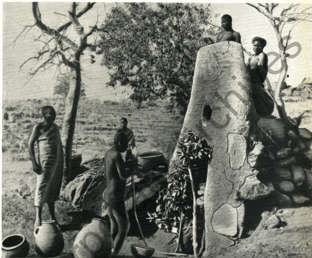
▲ Gesamtansicht eines Hochofens der Matakam-Neger. Oben sitzt der Blasebalg-Mann und traktiert seine Felle. Durch das über der Ofenöffnung zu erkennende kreisförmige Loch wird der Ofen in regelmäßigen Abständen beschickt. Aus einer Tonschale wird etwa alle 20 Minuten Erz und neue Holzkohle hinzugeschüttet.
