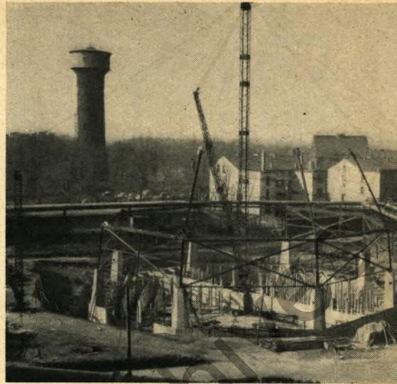
▲ Bereits im Februar begannen die Ausschachtungsarbeiten am Kühlturm auf EO II. Der Kühlturm, der im Rahmen des Bauwerks errichtet wurde, konnte Ende September in Betrieb gehen.
